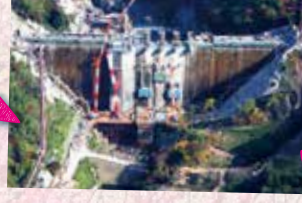
ハツ場ダム工事見学ツアー!
